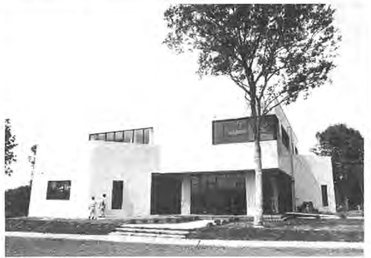
完成した農業研修センター管理棟
