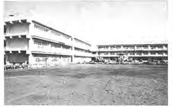
▲田中小学校から分離して開校する花野井小学校(花野井1684-1)＝写真＝は、建設費6億3950万円で鉄筋コンクリート3階建て、普通教室21、特別教室6。建物の延べ面積は4,324平方メートル。松葉二小(松葉町2-16)は、松葉一小と第四小学校から分離して開校。建物の延べ面積4,105平方メートルの鉄筋コンクリート3階建て、普通教室18、特別教室6で建設費は5億8540万円
