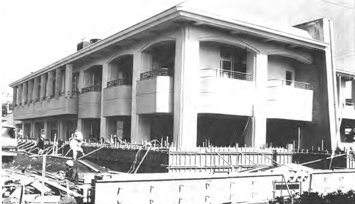
▲地区ふるさと運動の拠点となる近隣センターは、今年度光ヶ丘地区と新富地区に建設しています。光ヶ丘近隣センター(仮称)＝写真＝は、光ヶ丘団地200-1に、鉄筋コンクリート2階建て、延べ面積1,460平方メートルで市出張所も入る近隣センターとして建設費2億7335万円で建設を進めています。一方、新富近隣センター(仮称)は、豊四季945-1の稲荷神社境内に鉄筋コンクリート2階建て、延べ面積876平方メートル。建設費は1億9120万円で同センターには、ゲートボールなども楽しめる広場も同時に整備される予定
