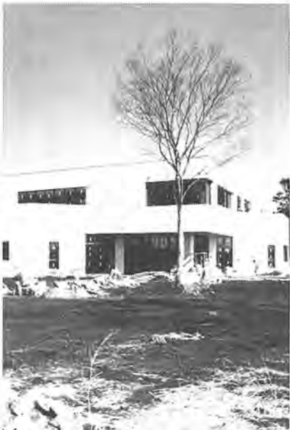
▲昭和55年度から5カ年の継続事業で柏市布施に建設が進められている農業研修センター(仮称)。今年度は、鉄筋コンクリート2階建て、延べ面積866平方メートルの管理棟を建設しています。新年度にはこの一部が使えるようになり、農業関係の会議や研修会などにも利用できるようになります
