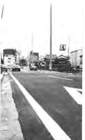
歩行者や自転車利用者など、安全で快適な歩道や自転車専用道を確保して進められる道路整備
