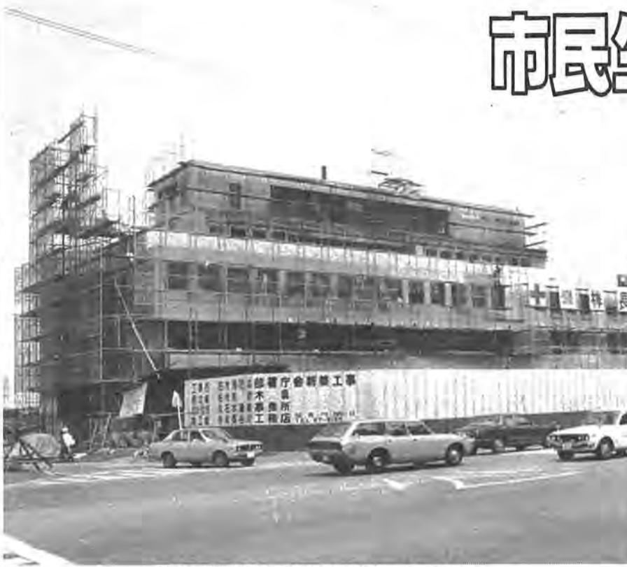
9月の業務開始にむけて、順調に工事が進む 消防本部・西部消防署庁舎 [柏市十余二]
