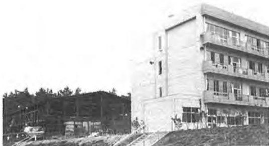
▲〔小・中学校〕現在、市内にある小学校は24校、中学校は11校。のびのびとした子供に育てもらうため各小・中学校には、プールと体育館が整備されています。今年開校した増尾西小(写真)では、今、体育館を建設中。
