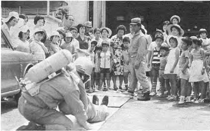
▲〔消防本部・消防署〕市民の生命と財産を守り、安心して暮らせるよう昼夜休みなく防火と救急に努めています。高層ビル火災や化学火災の出動に40メートルはしご車、救助工作車など最新鋭の装備がなされています。より消防力アップのため現在、国道16号線沿いの若柴に、消防本部・消防署を移す計画が進められています。
