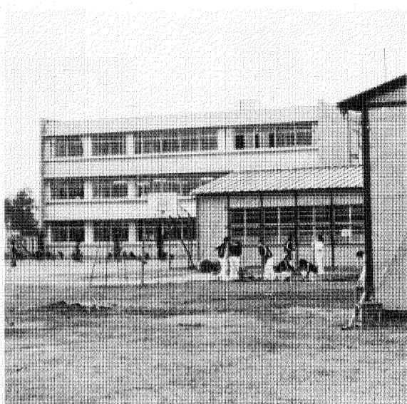
プレハブ教室(手前)を解消するため富勢中学校増築することになった
