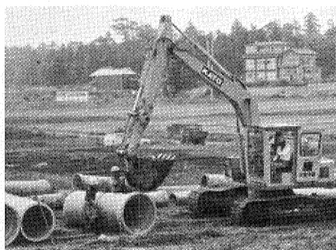
来春完成をめざして、工事が進む北柏駅南口土地区画整理事業
