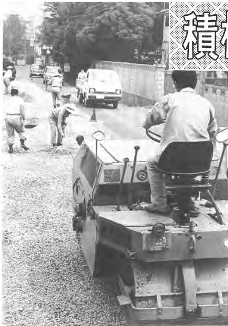
ほこりとドロ道から舗装道路にかわり、快適な生活環境への足固めを着々進めています
