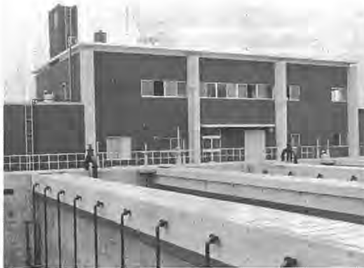
処理対象人口28,000人、1日10,600トン を処理する篠籠田の終末処理場
