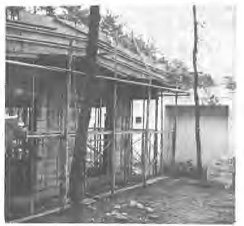
婦人児童センターとなり建設中の「老人いこいの家」
