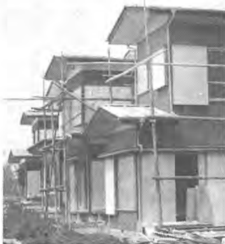
強い措置がとられることになった違反建築物
