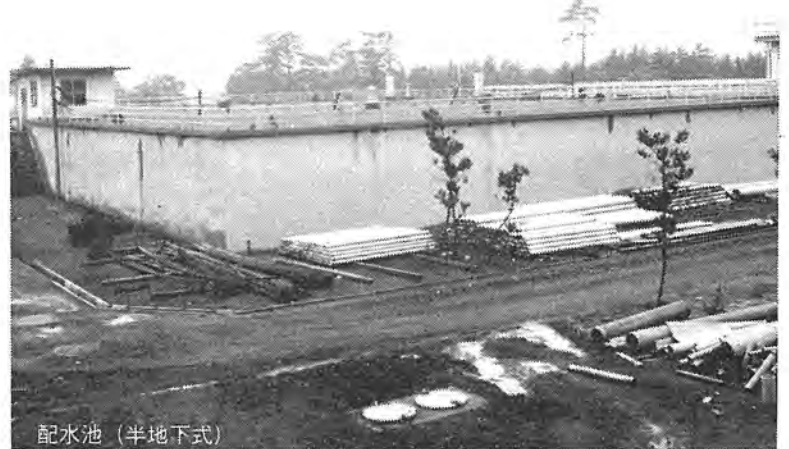
▲ 井戸からくみあげた水は、塩素滅菌し配水池にたくわえられ、ピーク時でも断減水のないよう配慮されます。
