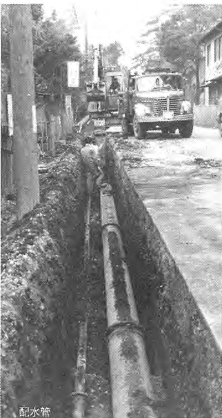
▲ 配水管に送られた水は、各家庭からの給水管へ接続され台所のじゃ口へ到達いたします。
