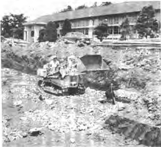
老朽校舎がこわされ鉄筋校舎の基礎工事が始まった四小
