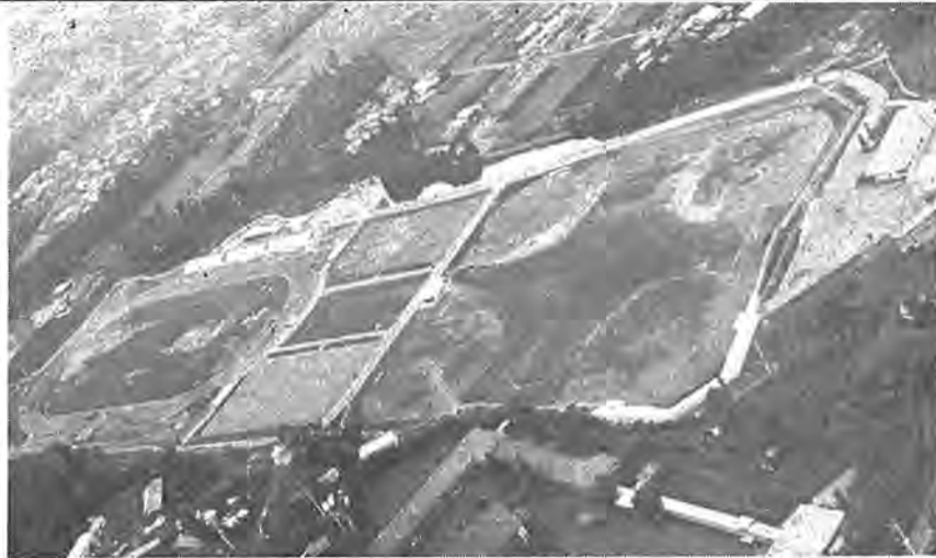
出来上った総合運動場(写真右から野球場・テニス・バレーコート・陸上競技場)
