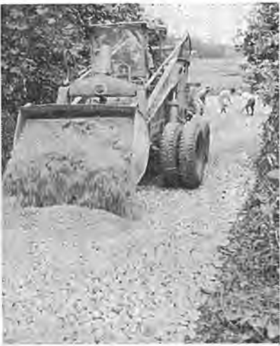
西町通りの舗装工事
