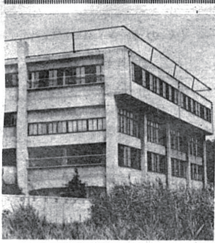
使用始まる旧豊住センター施設
