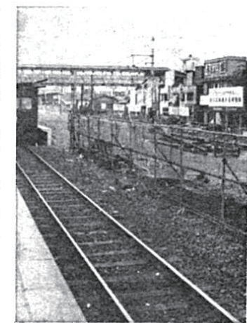
複々線工事の進む松戸駅
