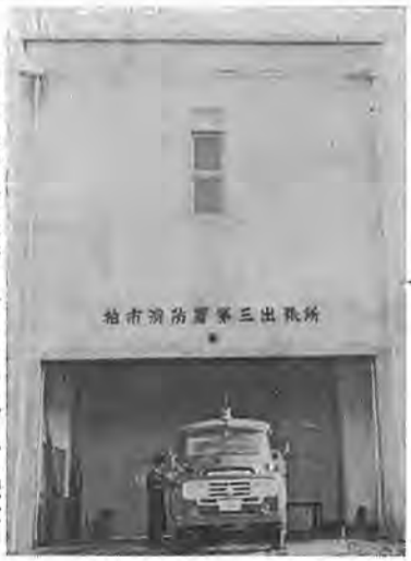
新設置のオ三出張所 新しいポンプ車も配置
