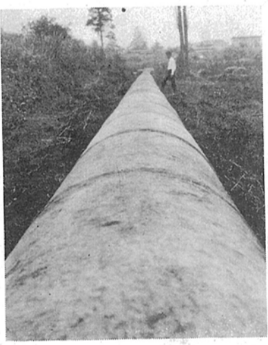
ひびりが丘に布設された排水管
