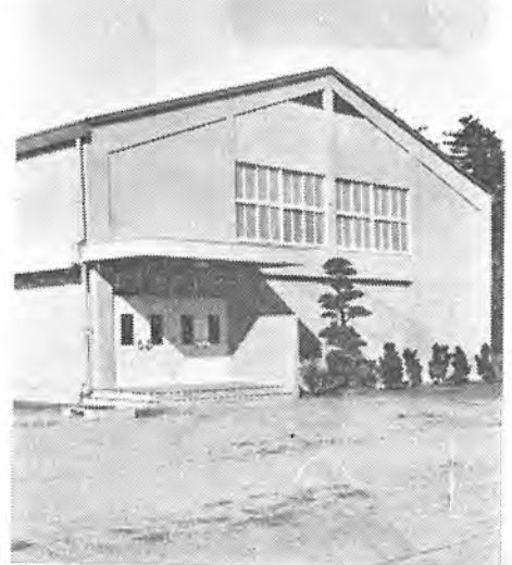
473平方メートルの床面積と整った照明設備をもった才四小学校体育館
