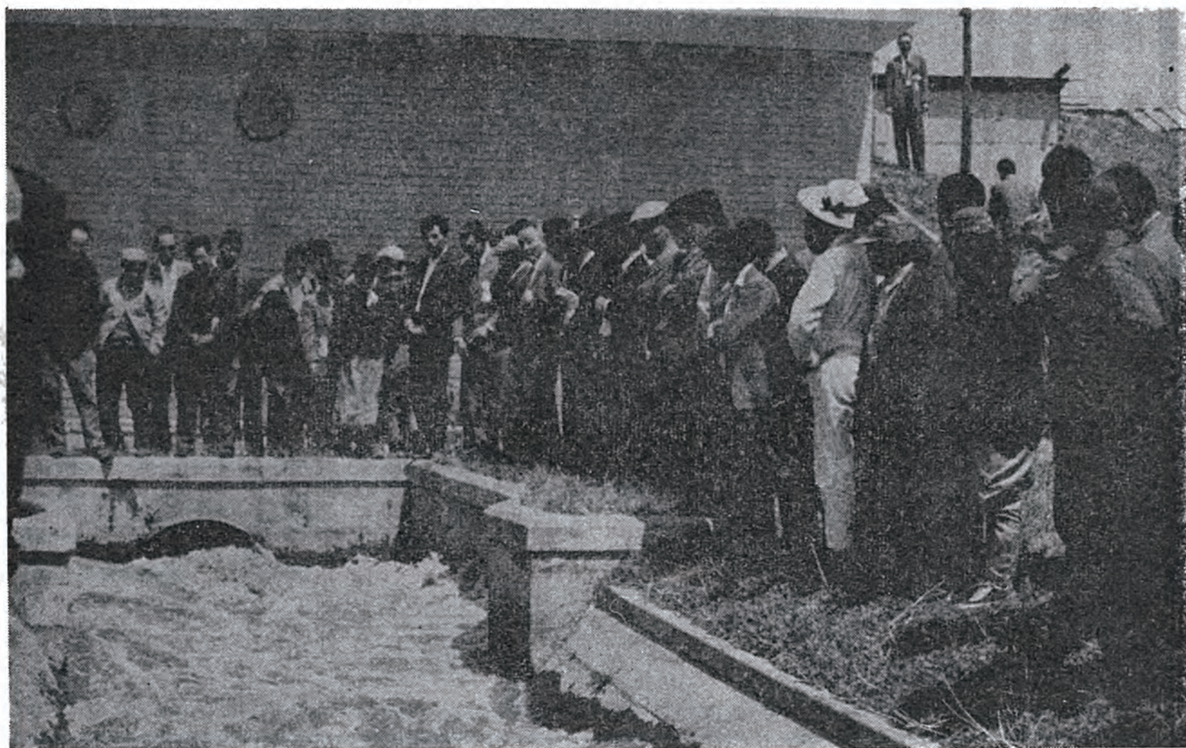
揚水を始めた船戸揚水機場
