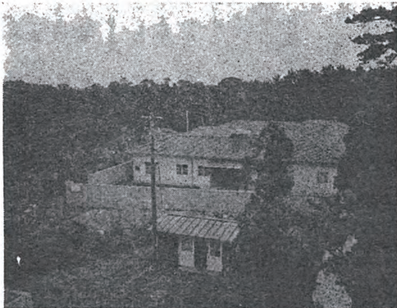
(6)完成した伝染病隔離病舎 東葛中部地区総合開発事務組合では、国立柏病院敷地内に伝染病隔離病舎(ベット数30)を完成(6月)
