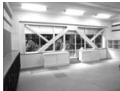
▲耐震補強された校舎
