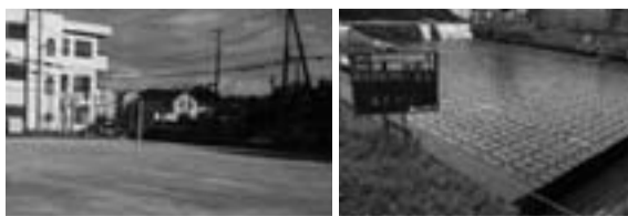
▲グラウンドの下には雨水を自然に返す仕組みが隠されています
