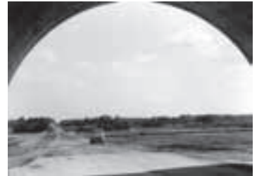
▲千葉方面を望む柏トンネル(昭和42年)
