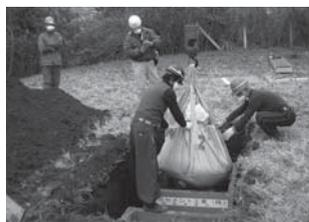
除染工事(コンクリート容器を埋設し、その中に汚染土壌を収容、上部に30センチメートルの覆土)
