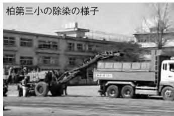
柏第三小の除染の様子
