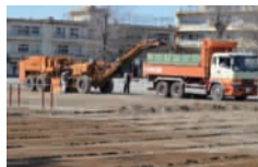
小学校の除染工事
