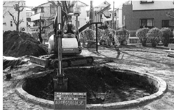
公園の除染作業
