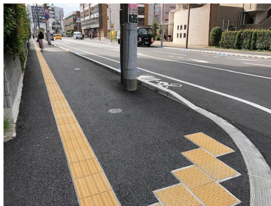
■ 南柏駅前線（施工後）
