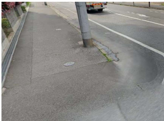
■ 南柏駅前線（施工前）
