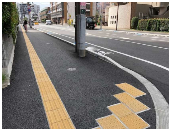
■ 南柏駅前線（施工後）
