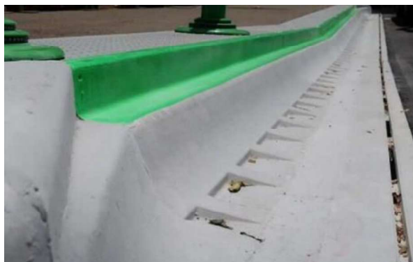
■ 新潟市における施工前・施工後のバス停車状況
