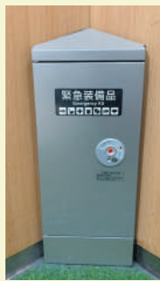
エレベーター内の防災備蓄ボックス▶
