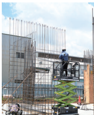
壁の基礎もしっかり固定
