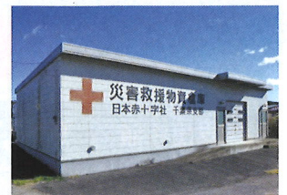
災害救援物資保管倉庫
