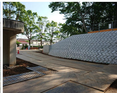
北側への進入路
