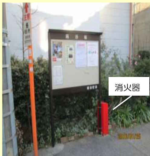
桜台町会の掲示板横に設置された消火器
