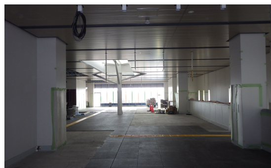
▲高柳駅橋上駅舎の 内観状況(工事中)
