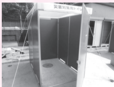
①トイレの壁となる仕切りを組み立てます
