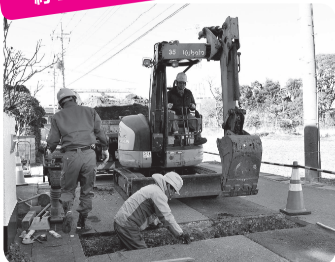
▲バックホウと呼ばれる重機で道路の土を掘り、工事が終わったら土を埋め戻す「開削工法」での工事の様子
