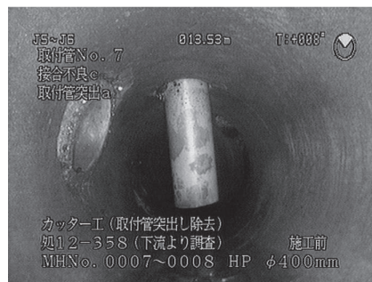
▲自走式カメラが捉えた下水道への取付管の突き出しや木の根の侵入の様子
