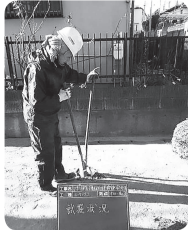
▲土を掘り起こして地質を確認します
