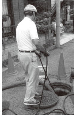
テレビカメラをマンホールに入れて点検しています
