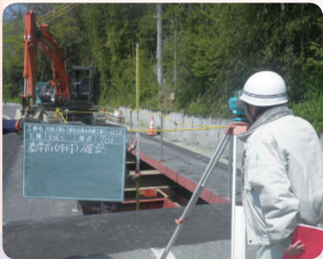
▲専用の機械で高低差を測ります
