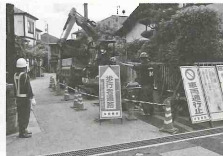
ただいま配水管改良工事中...
