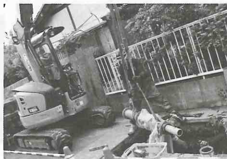
新しい管に交換!
