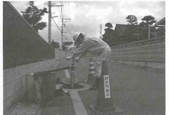
消火栓から排水作業中
