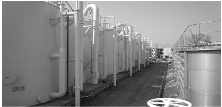
第三水源地ろ過機（平成24年度修繕）
