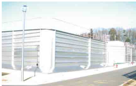
ステンレス配水池
