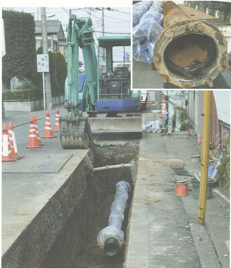
取替え工事の様子(右上は40年経過し撤去した管)
