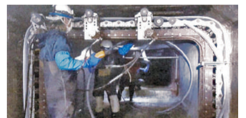
▲老朽管の更新・耐震化工事
