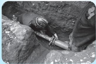
水道管(配水管)の取替え工事中！
