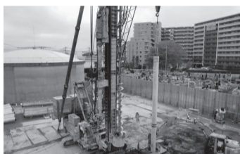
▲第五水源地配水池耐震化工事の様子
