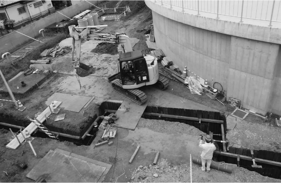
水源地施設耐震化工事の様子
