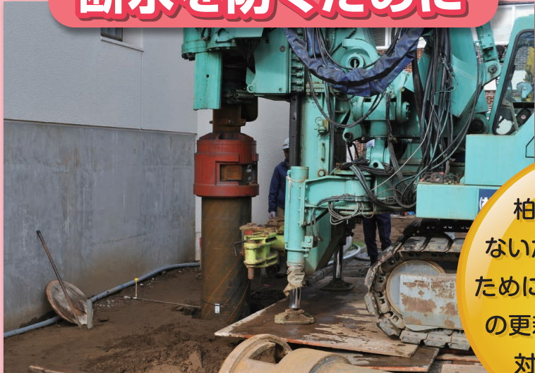
水源地施設耐震化工事の様子
