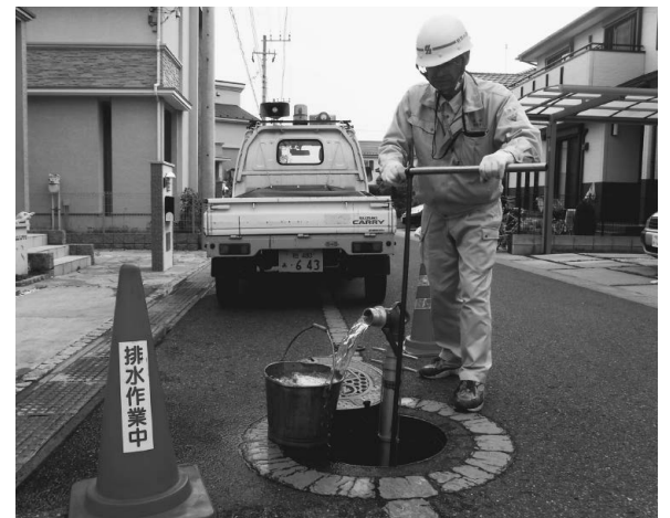
洗浄作業をしている様子
