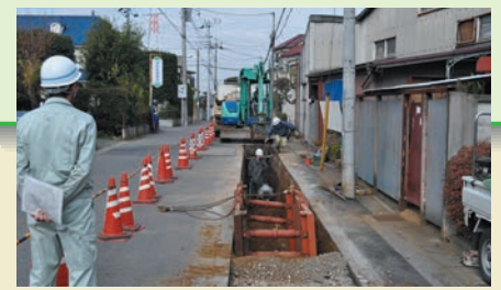
新しい管と交換している様子
