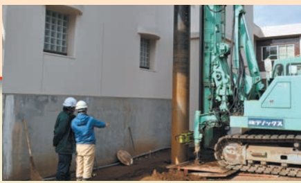
水源地の耐震補強工事をしている様子
