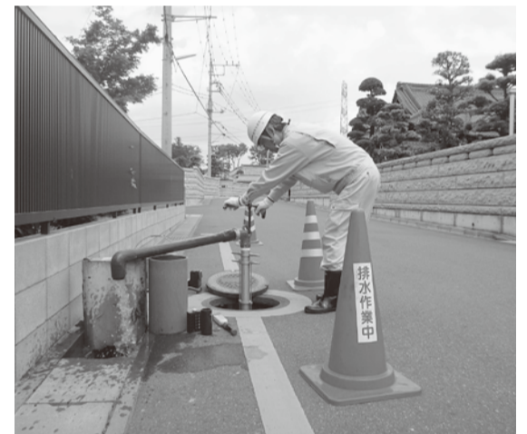
消火栓から排水作業中
